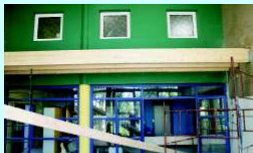
Przedszkole w Gierałtovicach - montaż dźwigarów stropowych
