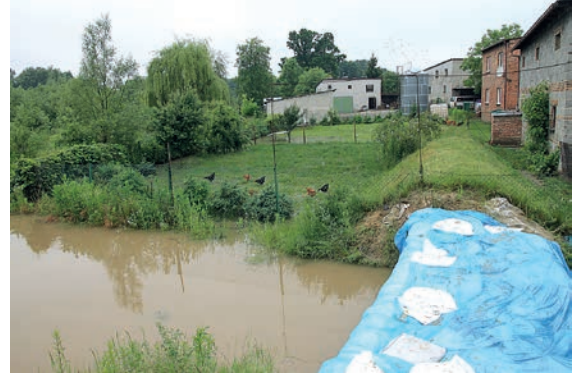
Strażacy ochotnicy z Przyszowic przezornie zamknęli prześwit komunikacyjny w wale ziemnym przy ul. Brzeg.
