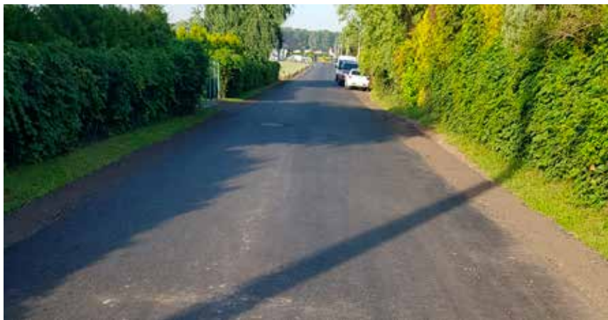
Remont nawierzchni ul. Kwiatowej w Chudowie.
