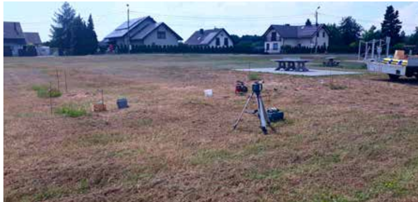
Wiata Chudów fundamentowanie.
