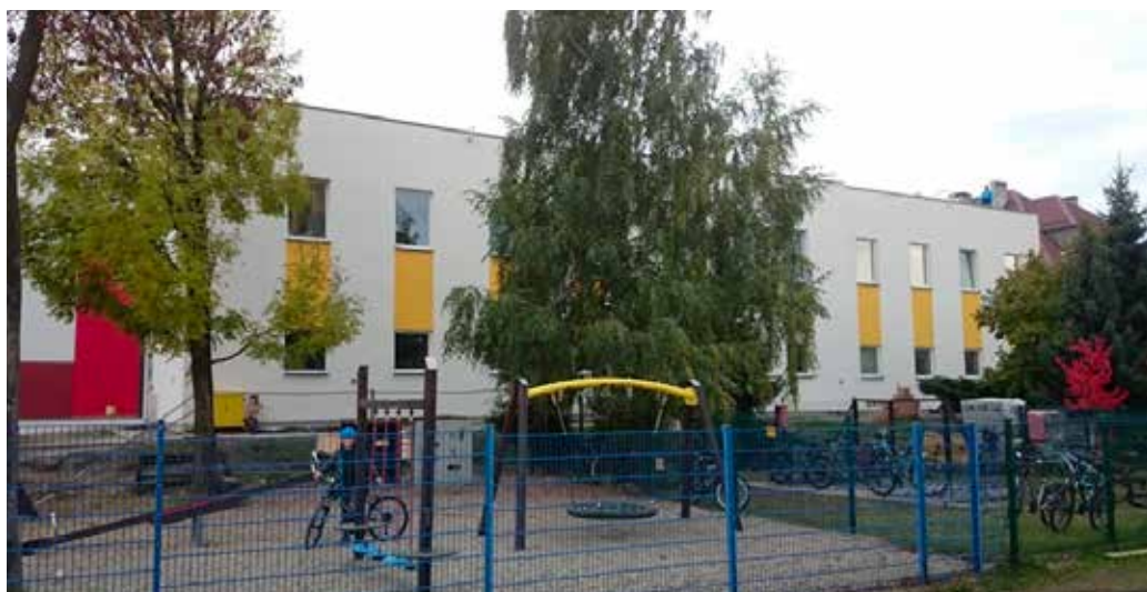
Kompleksowa termomodernizacja ZSP w Chudowie.
