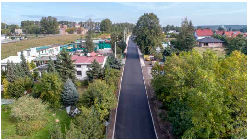
Przebudowa ulicy Granicznej w Przeszowicach.
