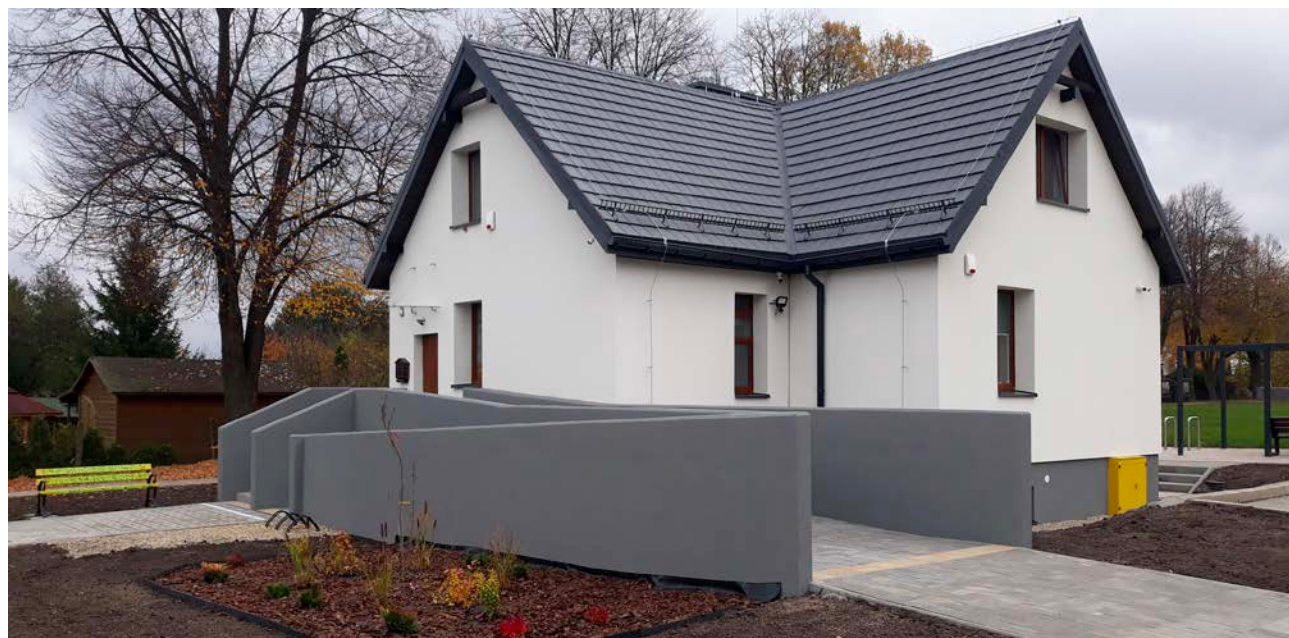
Budynek Gminnej Biblioteki Publicznej po termomodernizacji.
