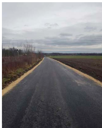
Wyremontowana ul. Brzezina.
