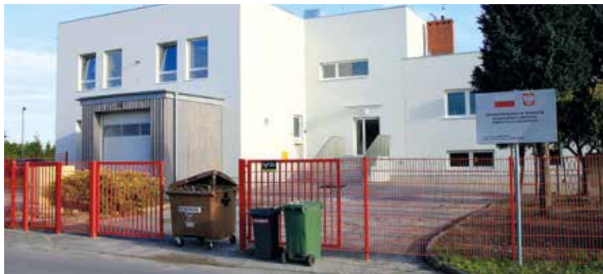
Na adaptacji pomieszczeń remizy na potrzeby przedszkola zyskał cały budynek.
