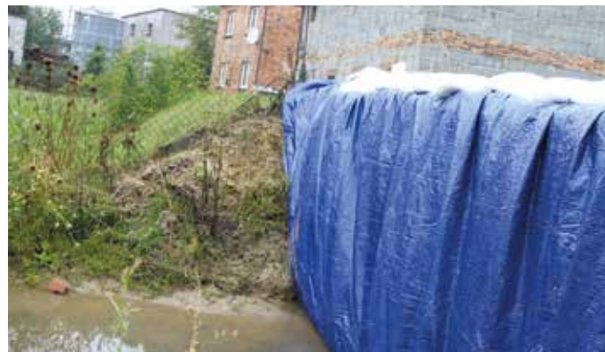
Tama z worków wypełnionych piaskiem, zabezpieczona folią, skutecznie zagradza przedostanie się wody za wał ziemny.
