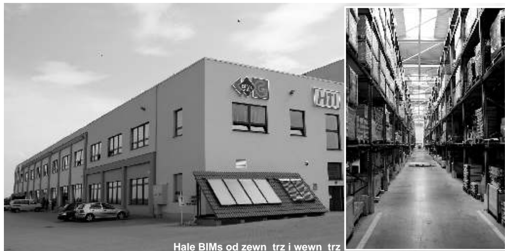
Hale BIMs od zewnątrz i wewnątrz
