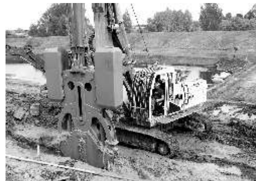
Przy wykonywaniu przesłony pracowała m.in. Casagrande - potężna maszyna, potrafiąca wykonać przegrodę do 28 m w głąb ziemi.
